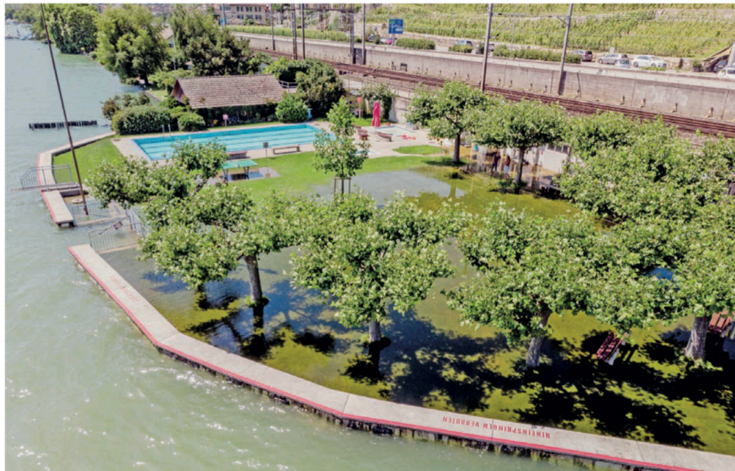
Beaver-Schläuche, wie sie beim Hochwasser 2021 bei der Badi Twann eingesetzt worden sind, können schlimmere Schäden abwenden.
